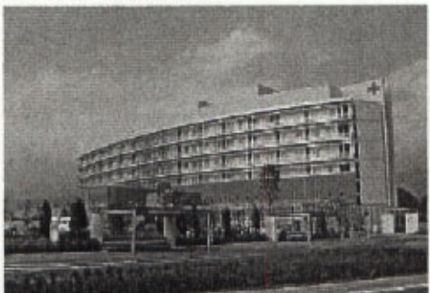
災時時の避難施設—主要な避難所における雨水リスク対策
